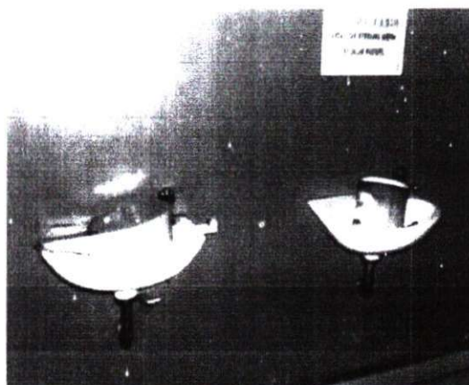
Gambar 2.11 Wastafel yang Tidak Berfungsi (Dokumentasi Peneliti, 2015)
