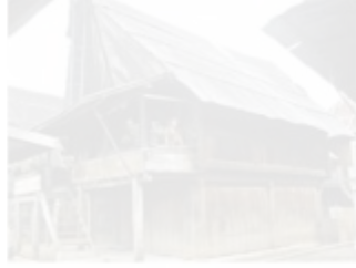
Gambar 10 Rumah Tunggu Tubang [33]
