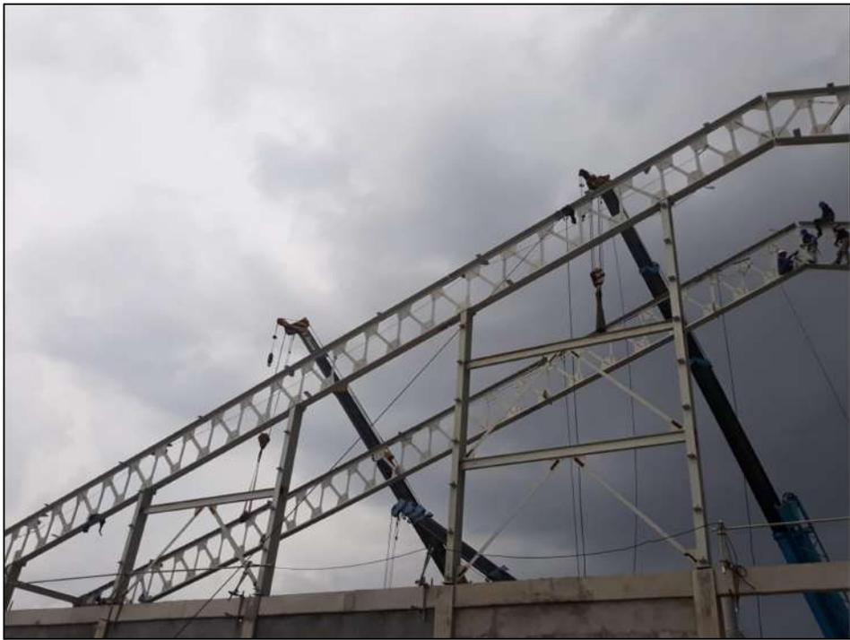
Gambar Erection Steel Structure dengan Rougher Crane
