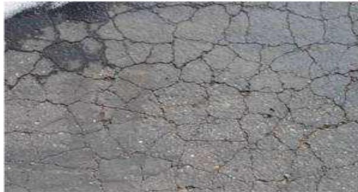
Gambar 2.11 Retak Susut
