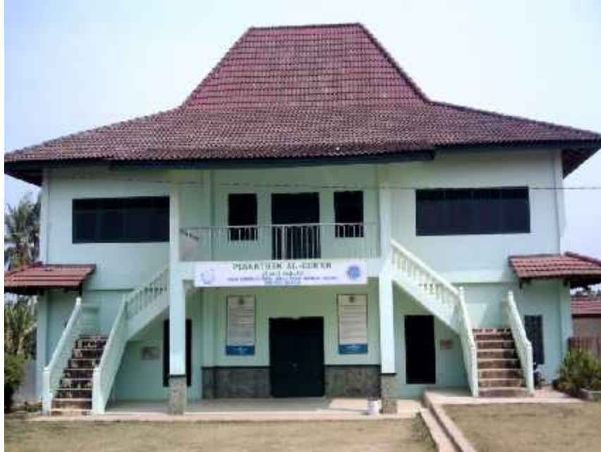
Gedung aula BKPRMI (lantai 2) dan lantai dasar digunakan tempat kegiatan Taman Kanak-kanak Al kahfi dan Taman Kanak-kanak Al Qur'an/Taman Pendidikan Al Qur'an Al kahfi BKPRMI)
