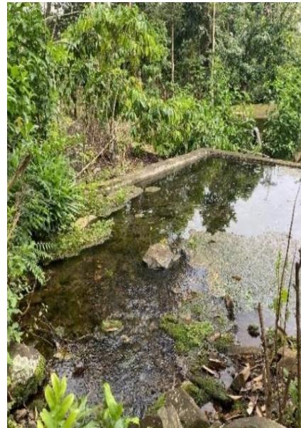
Gambar 3.2 Sumber Mata Air dan Bak Intake
