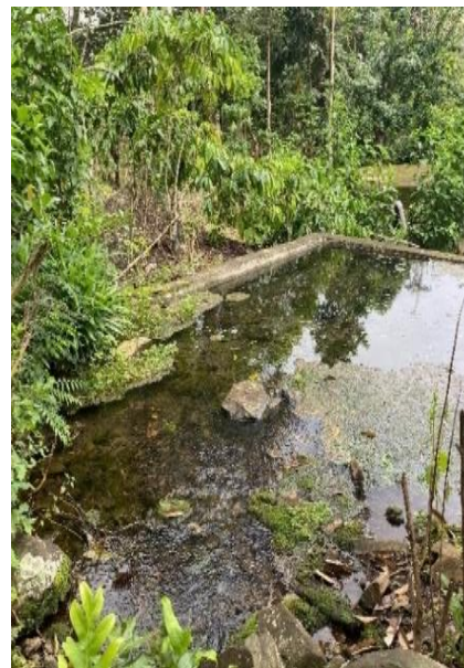
Gambar 3.2 Sumber Mata Air dan Bak Intake
