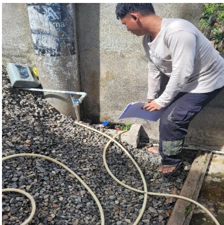
Pengecekan Meteran Air
