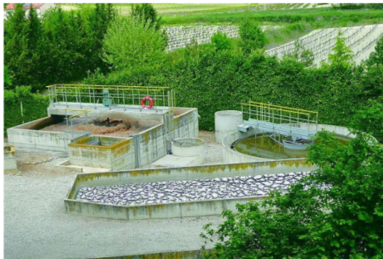
Gambar 4.2 Tanki Sedimentasi di Thailand
