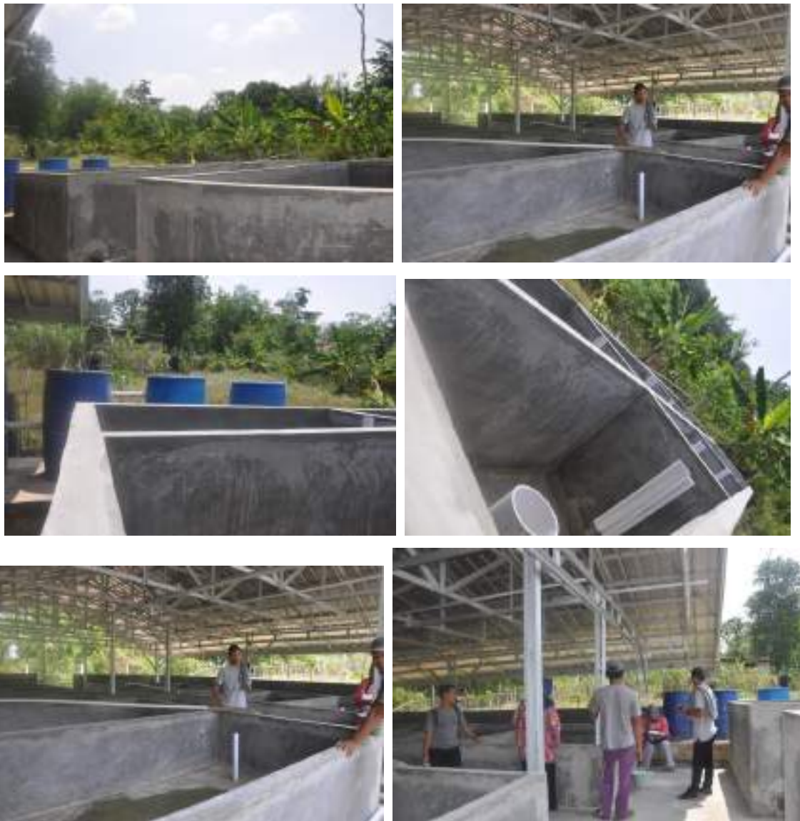
Gambar 8. Instalasi Penetrasi air di lokasi budidaya tambak Ikan Bintang Gandus, Binaan RU III Pertamina, Plaju
