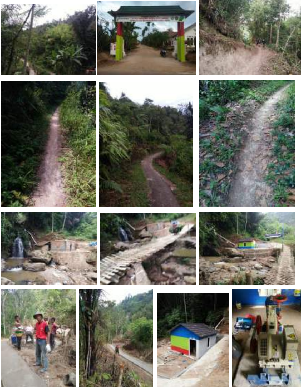
Gambar 3. Kondisi Kawasan Project Pengembangan Pembangkit Energi Listrik Bertenaga Mikrohidro (PLTMh) Sarwan
