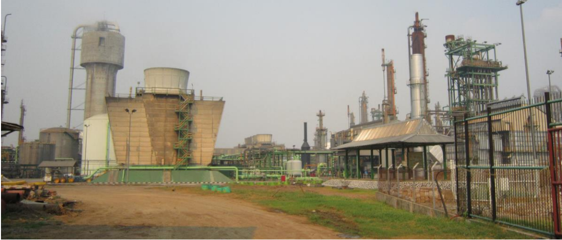
Gambar.... Kawasan pabrik PT. PUSRI
