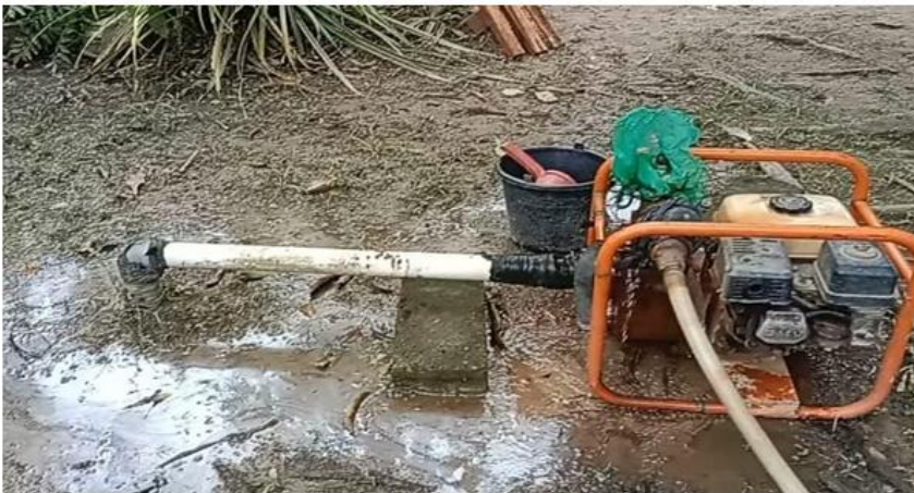
Gambar 17. Perangkat Sumur Bor Bantuan Untuk Miitra yang Sudah Terpasang
