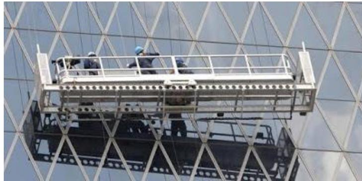
Gambar 2. 27 Gondola Untuk Perawatan Gedung
