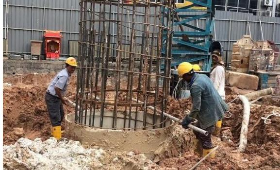
Gambar 4. 13 Pengerjaan Pondasi *Bored Pile*
