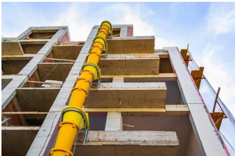
Gambar 4. 25 Cerobang/Pipa Vertikal
