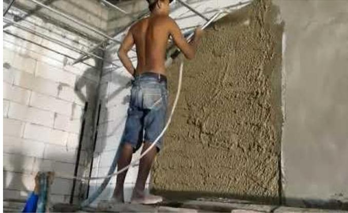
**Gambar 2.9** Penyiraman permukaan dinding dengan air
