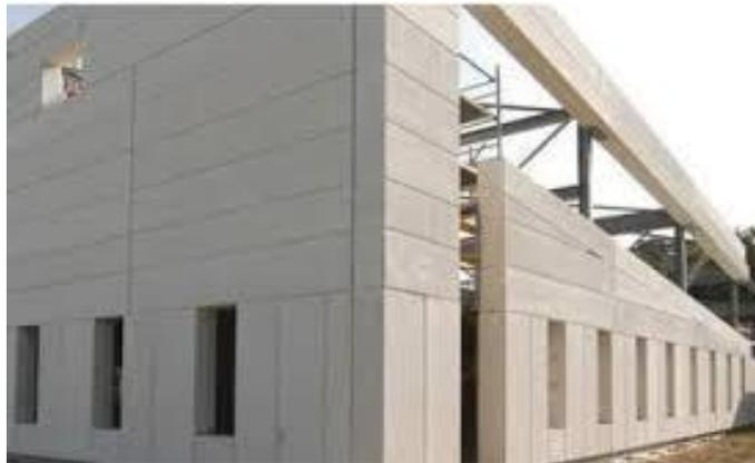
**Gambar 2.23** Dinding bata hebel atau celcon
