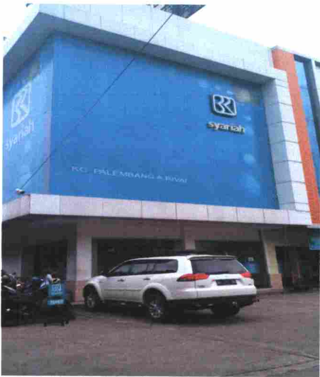
Gambar 1. Tampilan Gedung Kantor Cabang Bank BRI Syariah di Jalan Kapten Rivai
