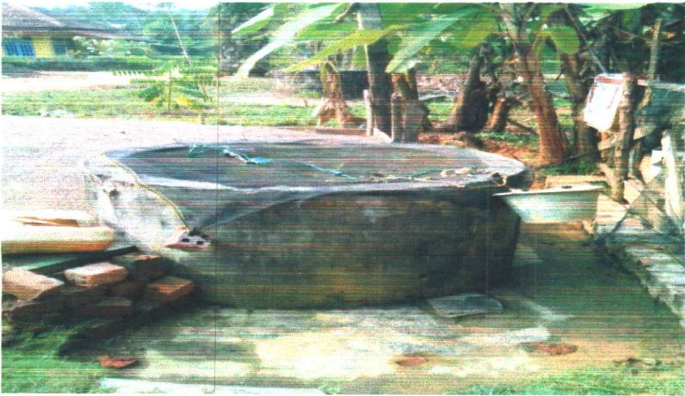
Gambar 1 Sarana Air Bersih (Sumur)
